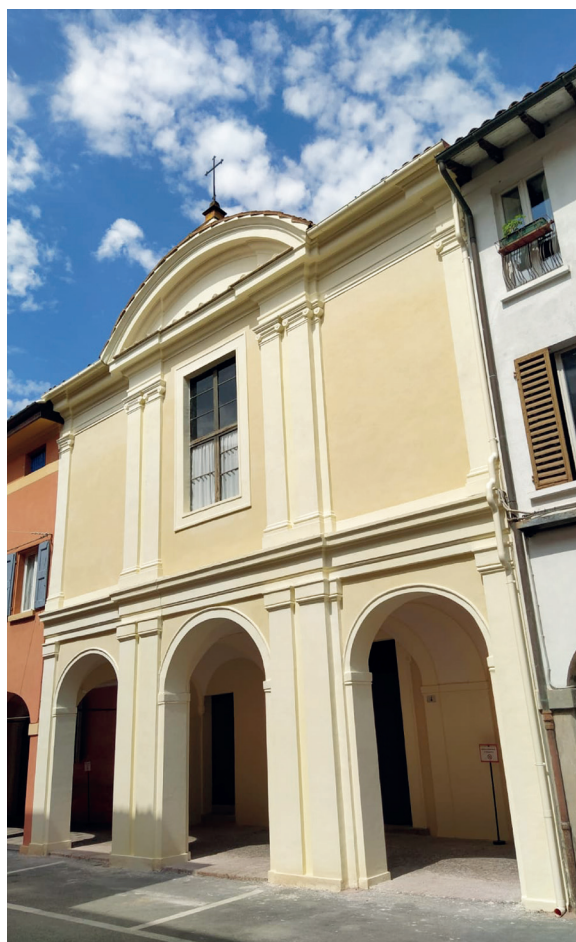
La facciata della Chiesa della Salute restaurata. Lavori svolti dalla Fondazione Donati-Zucchi Partenotrofo
