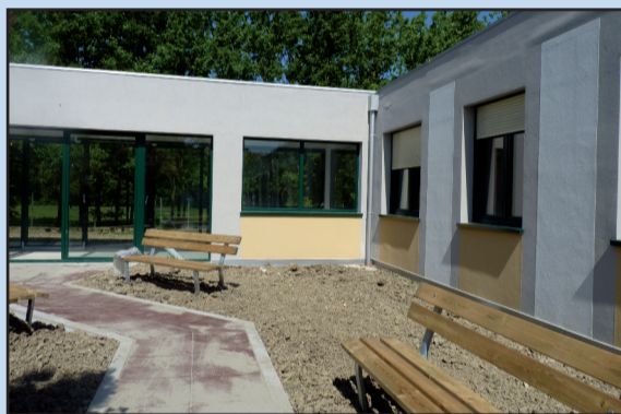
Nuovo cortile interno a disposizione degli ospiti
